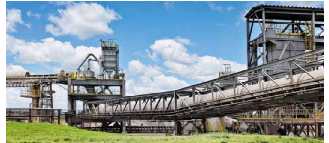
ESTERAS CUBIERTAS TRANSPORTAN EL CALCÁREO PARA DOSIFICACIÓN
