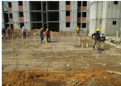
Figura 12. Armado parrilla inferior de la losa de cimentación.
