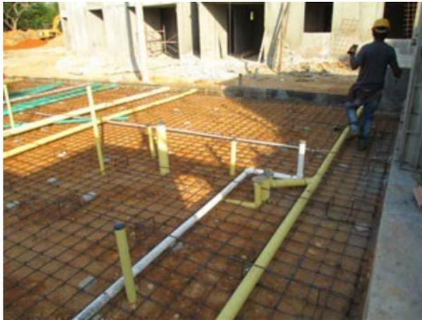
Figura 13. Colocación de tuberías hidrosanitarias y eléctricas.
