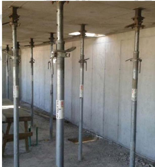
Figura 54. Apuntalamiento de losa en concreto.
