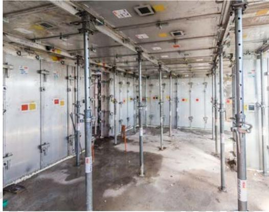
Figura 42. Apuntalamiento del encofrado de las losas.
