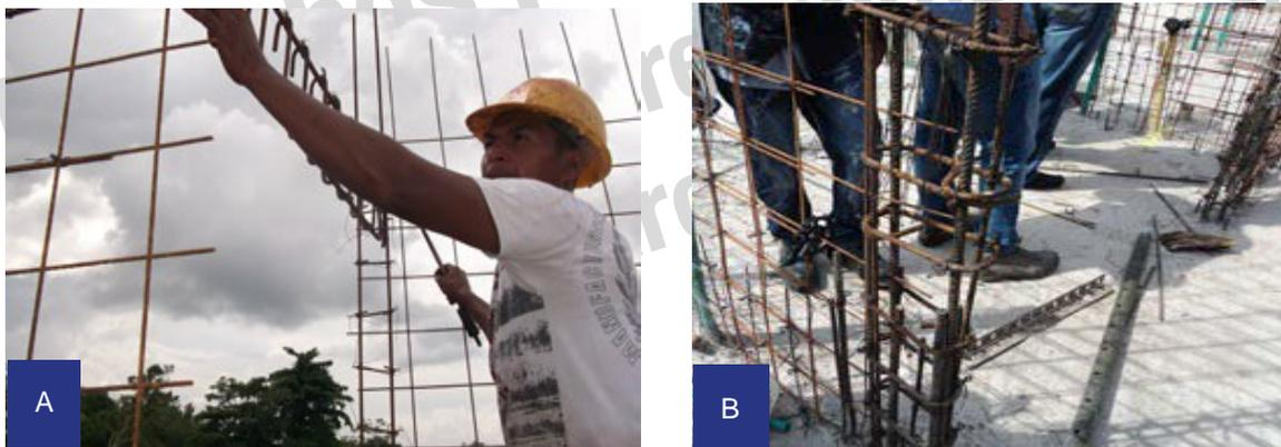
Figura 21. Refuerzo de dinteles y vanos de puertas y ventanas.
