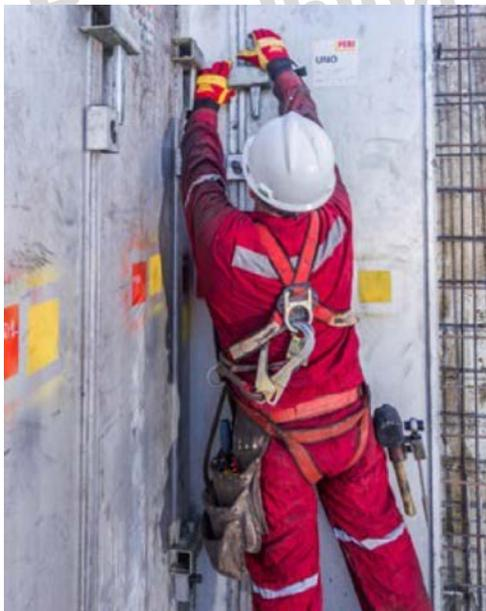
Figura 33. Fijación de paneles de encofrado: Cerrojos.
