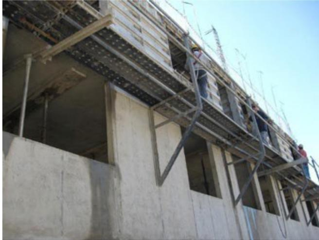
*Figura 57. Colocación de ménsulas.*
