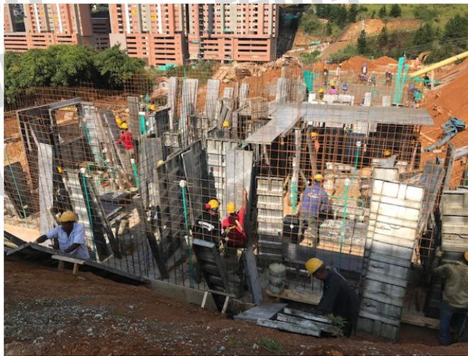
Figura 62. Mano de obra encofrado muros y losa.
