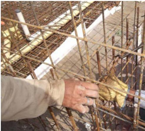
Figura 20. Colocación del refuerzo de los muros.
