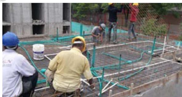
Figura 49. Colocación de refuerzo e instalación de redes en la losa.
