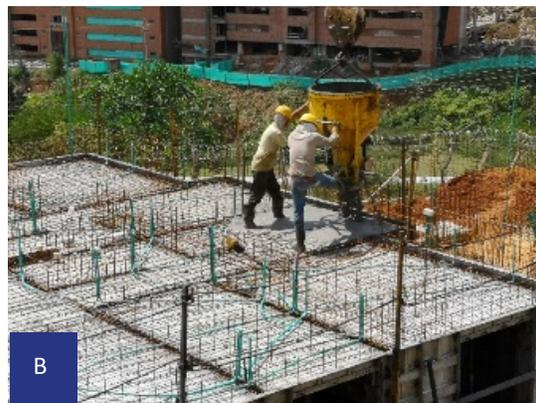
Figura 51. Vertido del concreto (A. Bomba. B. Balde).
