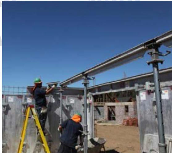
Figura 43. Viga especial de encofrado para armado de losa.
