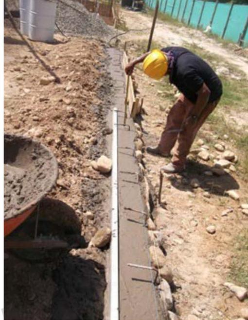
Figura 11. Construcción viga perimetral para losa de cimentación.
