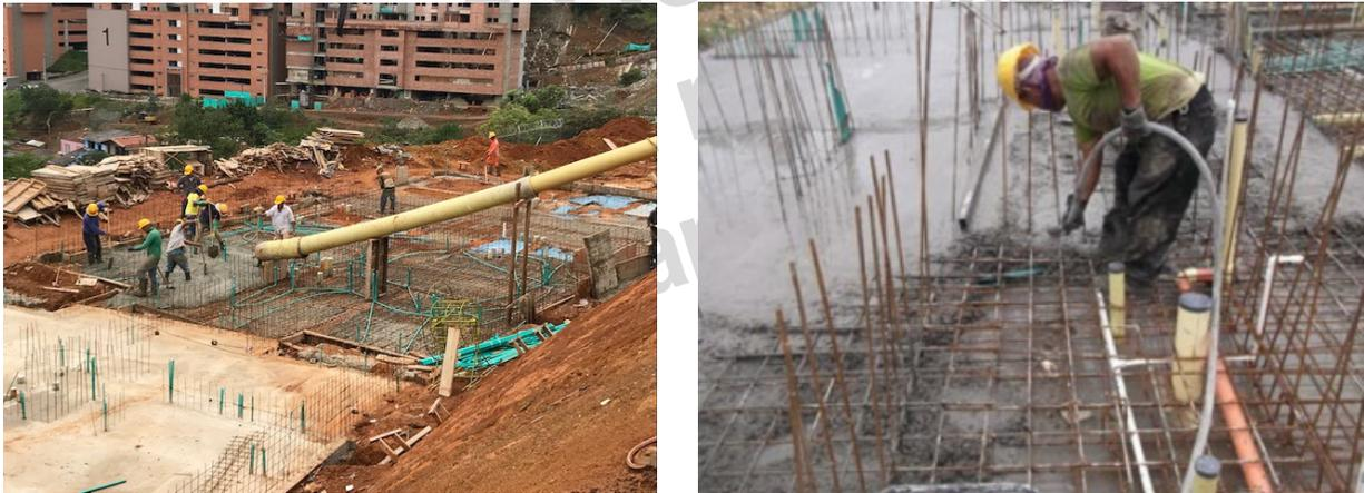
Figura 18. Vaciado y vibrado losa de cimentación.
