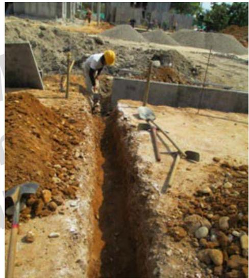
Figura 10. Excavación viga perimetral para losa de cimentación.
