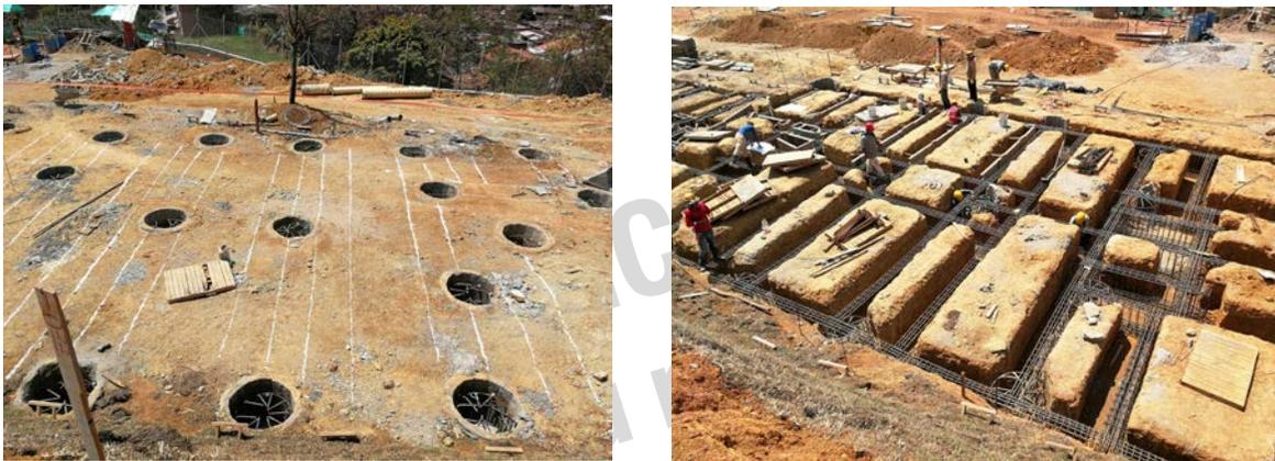
Figura 6. Ejemplo de cimentación mediante pilas y vigas de amarre para un edificio en altura.
