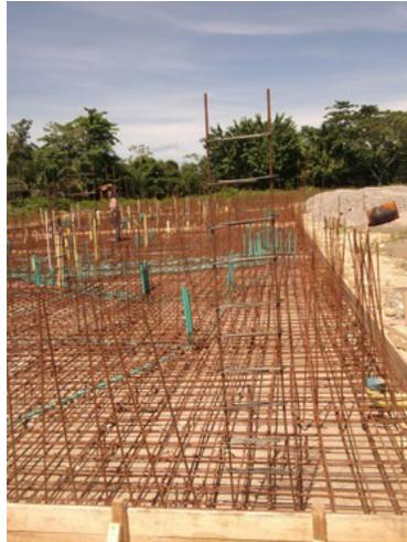
Figura 16. Colocación de encofrado perimetral para losa de cimentación.
