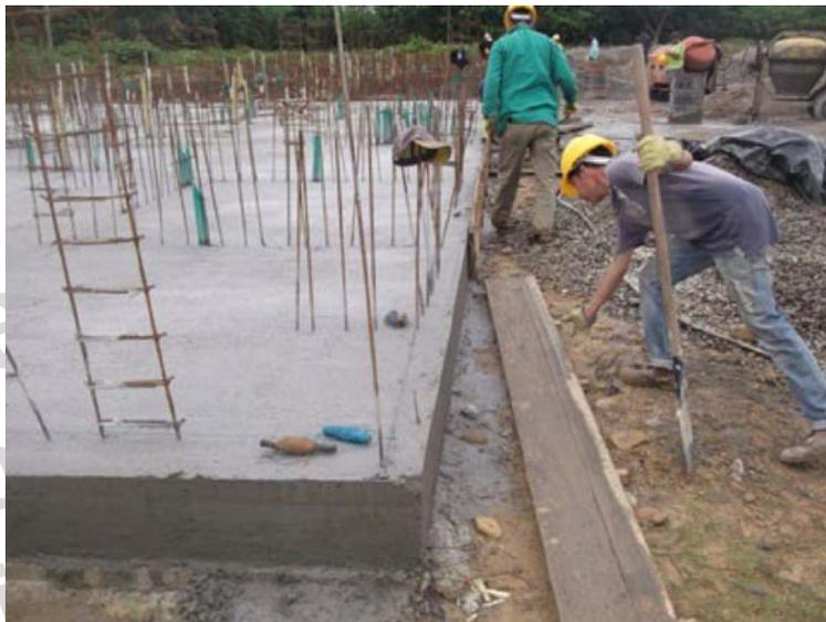
Figura 19. Desencofrado de la losa de cimentación.
