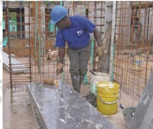
Figura 56. Aplicación de desmoldante.
