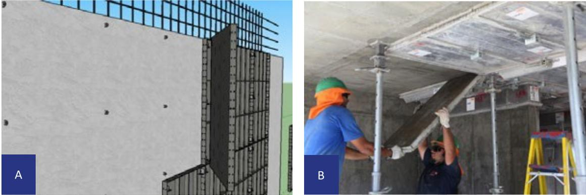
Figura 53. Retiro de paneles de encofrado.
