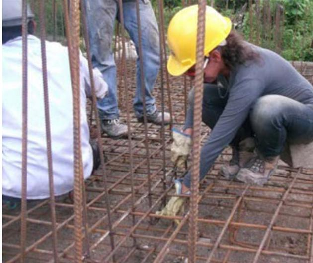
Figura 15. Colocación varillas de arranque de los muros del primer nivel.
