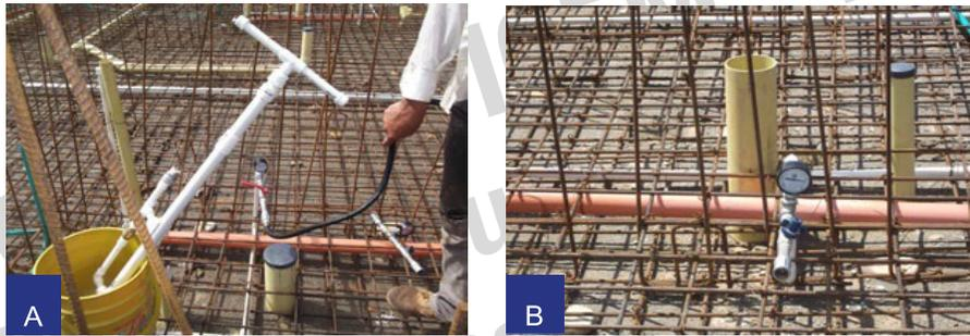
Figura 17. Prueba de presión para instalaciones hidrosanitarias.
