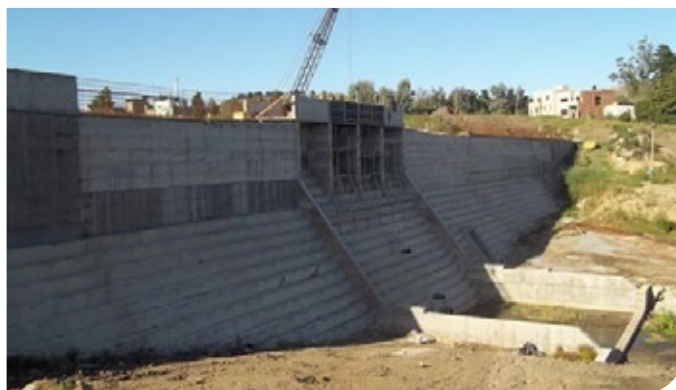
Figura 4.9. Presa de concreto compactado con rodillos, Tandil, Buenos Aires, Argentina.
