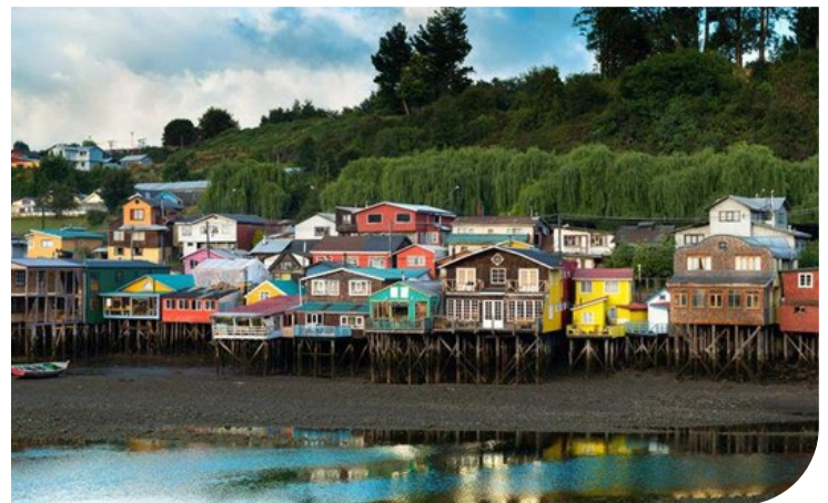
Figura 4.14. Uso de pilotes de madera. Chiloé, Chile. (Qualviagem, 2016).
