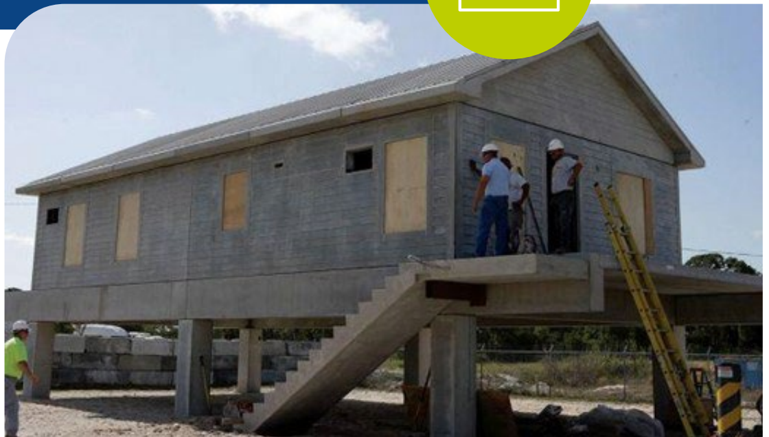
Figura 4.16. Casa con elementos estructurales prefabricados de concreto desarrolladas para resistir huracanes. Según el fabricante, soporta vientos de hasta 280 km/h (Itambé, 2017). La base de la casa se eleva a 1,8 m sobre el suelo, lo que permite un buen comportamiento frente a las inundaciones.
