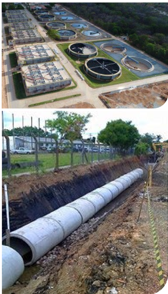
Figura 4.4. Tuberías prefabricadas de concreto para alcantarillado y agua de lluvia (Izq). Planta de tratamiento de aguas residuales (Der.).
