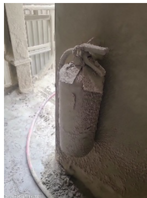
Extintor afectado por la proyección de material con temperatura debido a una presión positiva desde el horno
